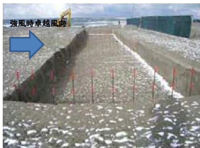
写真 2-5 トレンチ掘削直後 (2月1日撮影, 陸側より)
