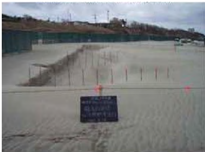
写真 2-6 第3回測量時（2月18日撮影，海側より）
