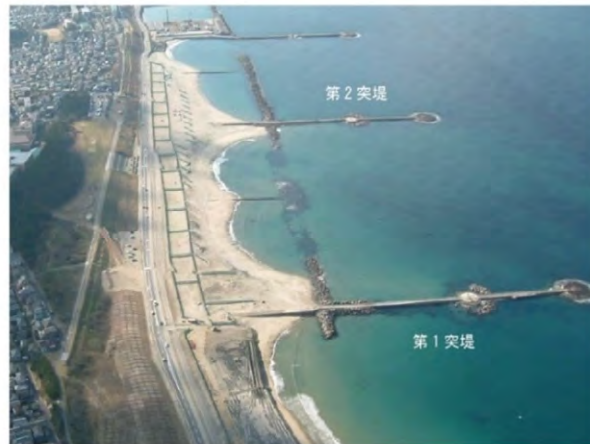
写真 2-4 翼堤と2列フェンスによる飛砂対策工
