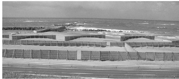
(b) 陸側から見た堆砂垣群
