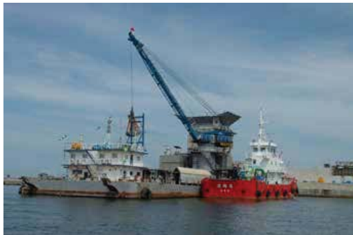
護岸に張り付くコンクリートミキサー船
