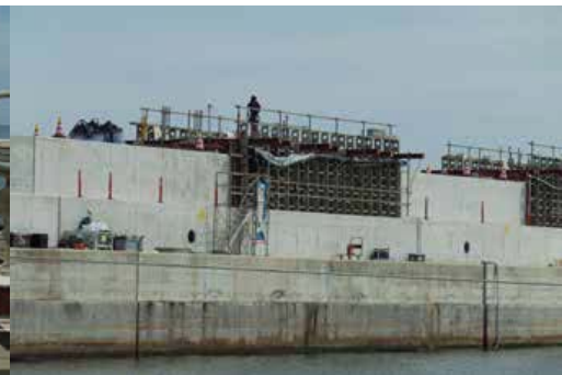
コンクリート打設を待つ2層めの型枠
