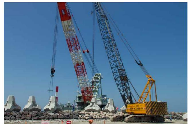
海辺のブロックヤード。起重機船に積む クレーンと、敷地内を移動させるブロック を運ぶクローラークレーンが、それぞれに エンジン音を響かせている。
