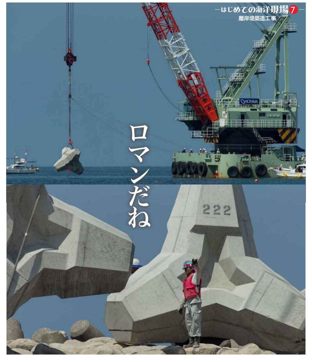
未来の時間のために、男たちが体を張って波消しブロックを海底に据付けている。いつまでも住民が 憩い、どこよりも白くて小粒な砂がある浜を誇れるように、屈強な男たちが汗を流している。ここは 新潟西海岸の一画。市民が釣りや海水浴を楽しむ浜のすぐ沖で、離岸堤の延長工事が行われている。 未来の時間のために、人の目にふれることのない海上で、この地域特有の海流を考慮した独自の設計 を採用した工事が進んでいる。たとえ構造物が見えなくても、昔の砂浜を取り戻すために、今日も最 新のテクノロジーと男たちの共同作業が行われている。
