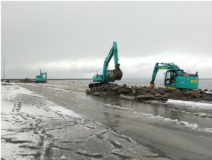
②応急復旧工事施工状況(舗装版取り壊し(2/6(火)撮影))
