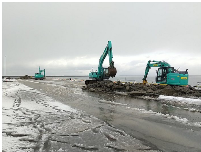
②舗装版取り壊し状況(R6.2/6(火)撮影))
