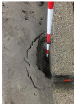
点検時写真・小規模な陥没箇所の発見
