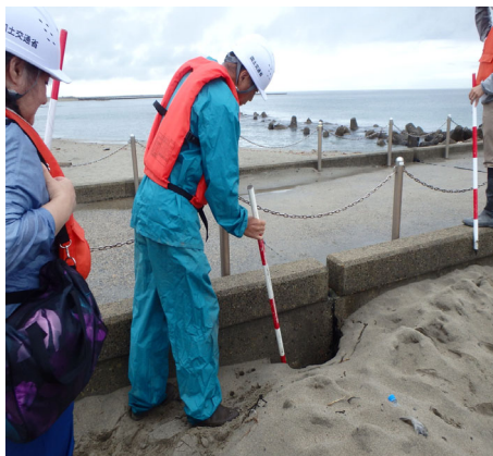
点検時写真・小規模な陥没箇所の発見
